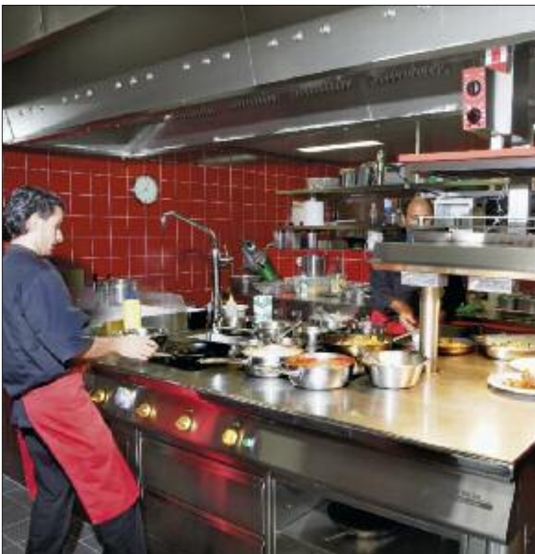
Die höchst effiziente und genial eingerichtete Restaurationsküche der Hugentobler AG.
