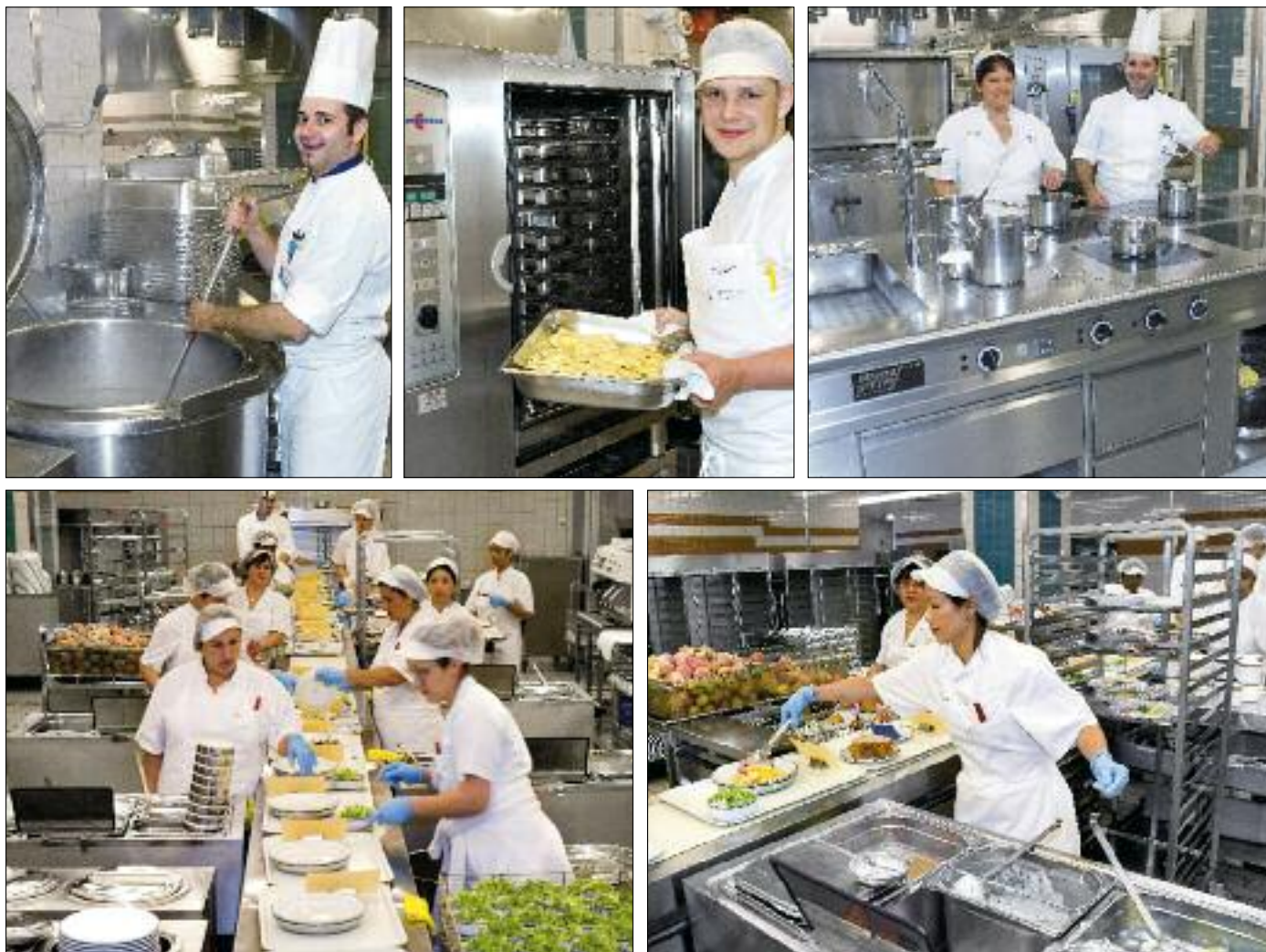
Top-ausgerüstete Hauptküche, effiziente Speiseverteilung im Luzerner Kantonsspital: Laufend wurde in die neueste Küchentechnik investiert.
